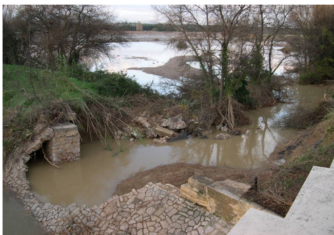
Dégâts sur une digue (Mosson - 12/2003 - photo DDTM)
