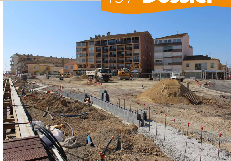
Place Panis - Construction mur soutènement
